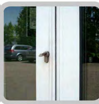
Mechanische Türverriegelung (Hakenverriegelung) bei Frame
