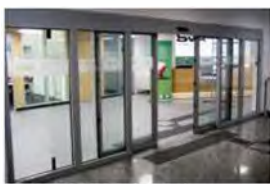
Automatiktür in St. Pölten
