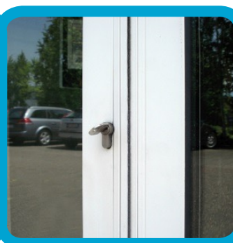
Mechanische Türverriegelung (Hakenverriegelung bei Frame)
